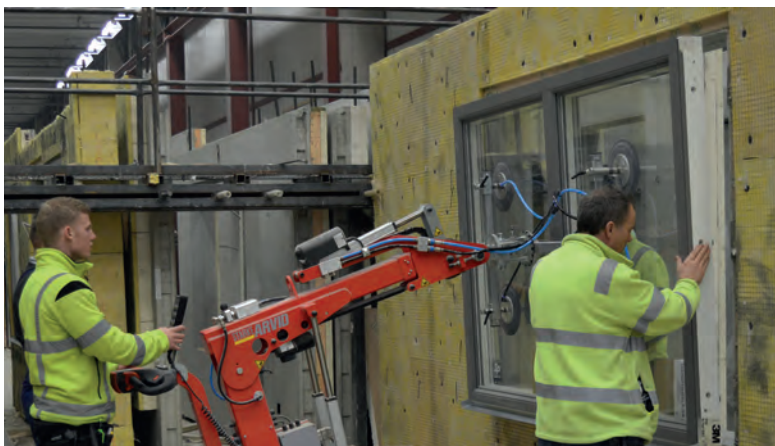
Fabriksmonterade komponenter förenklar arbetet på byggarbetsplatsen.
