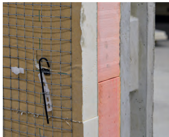
Högvärdig isolering ger goda energiegenskaper.
